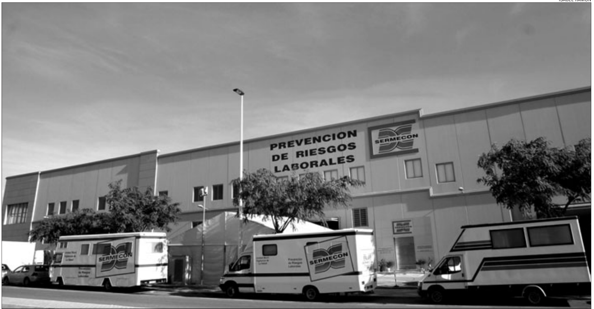
Vista de la fachada de la nave, de 800 metros cuadrados, de las instalaciones de la empresa Sermecon en el Parque Industrial de Elche, en la que pueden verse también las unidades móviles
